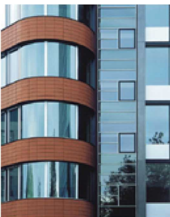
sGG COOL-LITE ST 150 (bombé), SKN 165B NH Hotel Francfort, Frankreich KSP Architekten
